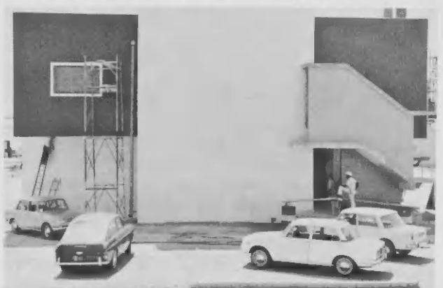
Refining Control Center nobo manera e lo bira, cu e edificio manera e tabata, na drechi.
